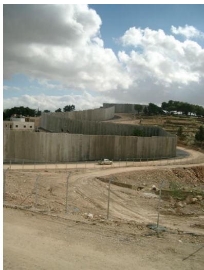
Il muro di 730 chilometri, che in Cisgiordania separa la maggior parte delle colonie israeliane e la quasi-totalità dei pozzi d'acqua dagli insediamenti palestinesi https://it.wikipedia.org/wiki/Barriera di separazione israeliana
